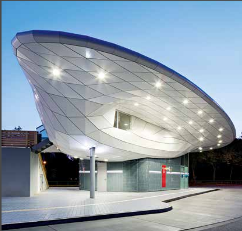
El techo suspendido en forma de ala de ALUCOBOND® PLUS blanco puro de la estación de autobuses de Hamburgo Poppenbüttel. | Foto: archimages
