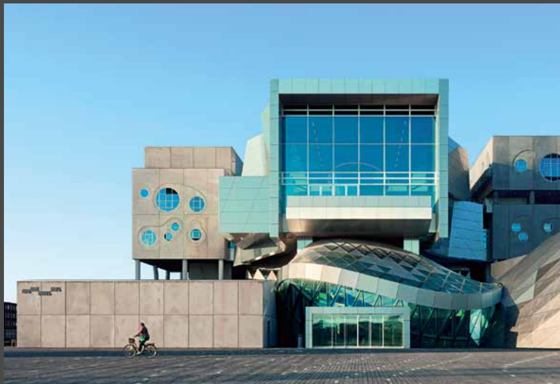
La fachada de paneles composite de aluminio ALUCOBOND® PLUS en naturAL Brushed confiere al edificio un carácter individual. | Fotos: Duccio Malagamba
