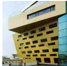
Pichler & Traupmann Architekten ZT GmbH, Viena, (AT) Raiffeisen Finanz Center, Eisenstadt, (AT) Fotografía de @paul ott
